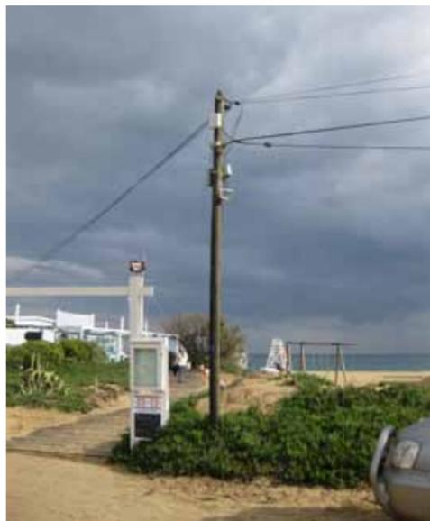
La quasi-totalité des dessertes Telecom des bâtiments de plage s'effectue en aérien générant une pollution visuelle importante. Dans le cadre du réaménagement de plage, il sera nécessaire au-delà des déconnexions nécessaires des bâtiments déplacés d'enfouir les réseaux de distribution Telecom.
