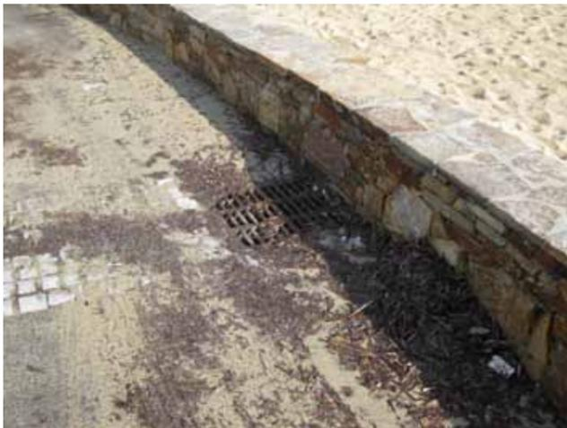
Grille d'évacuation des eaux pluviales en aval du boulevard Patch – colmatage complet de l'ouvrage
